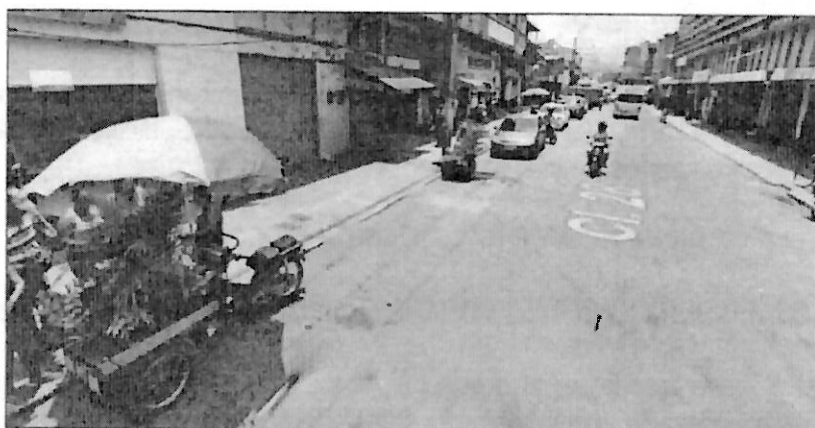
Calle 28— no se evidencia señales de transito donde exista la restricción de estacionamiento o parqueo
